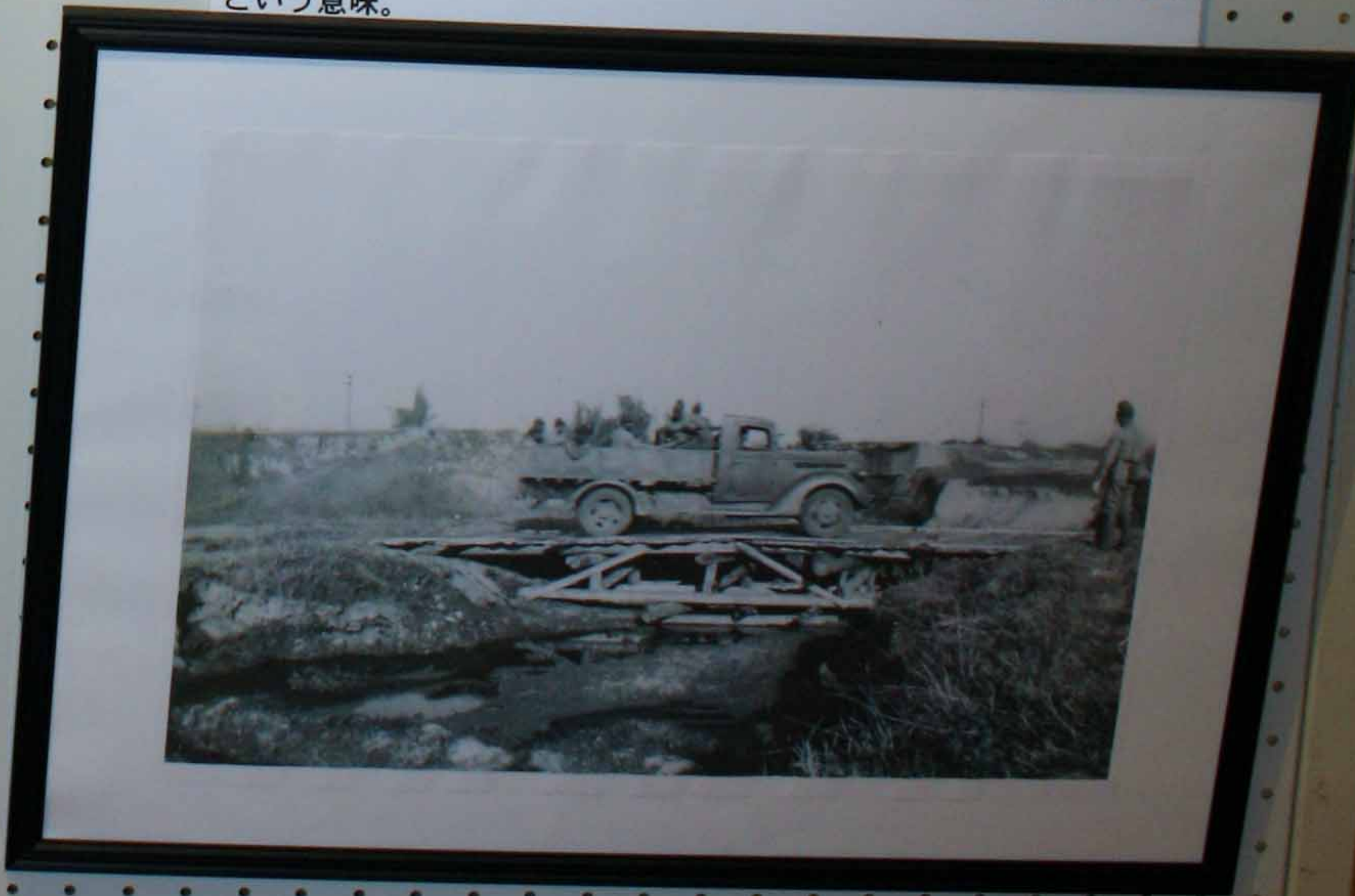
完成した橋を渡るトラック
