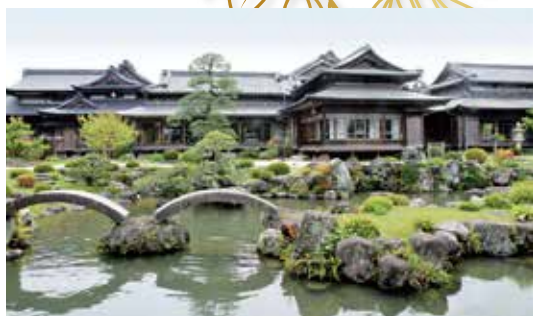
旧藏内邸 池泉庭園と建物群
